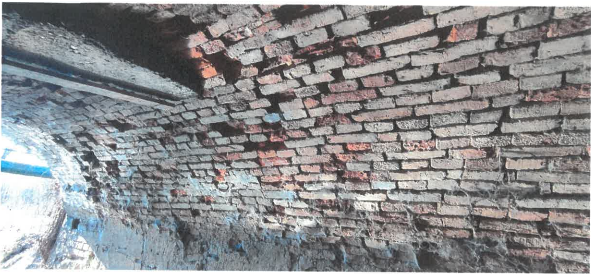
A boltozat folyás szerinti bal oldala a befolyási oldali fél, kissé behorpadt boltozati geometria, üres habarcszézagok, kiesett elemek, az eróziótól letöredezett félbetört elemek
