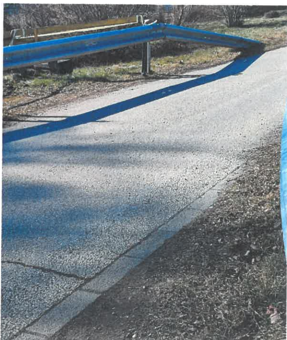
Az útpálya a műtárgy felett. Repedés a teherelosztó lemez végeinél, a műtárgy tengelyében jól láthatóan megsüllyedt a burkolat
